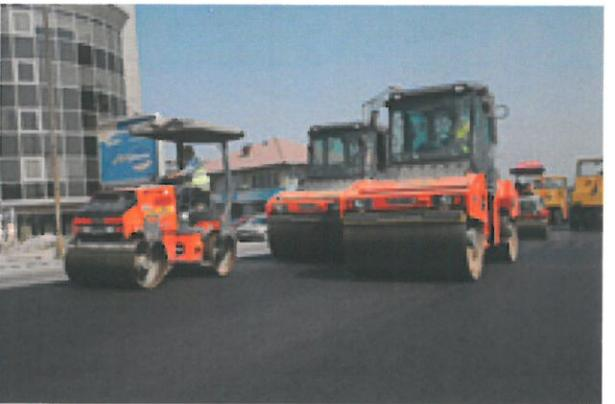
Дебелината на положените пластове ще се определя въз основа на ядки, извадени от завършения пласт.
